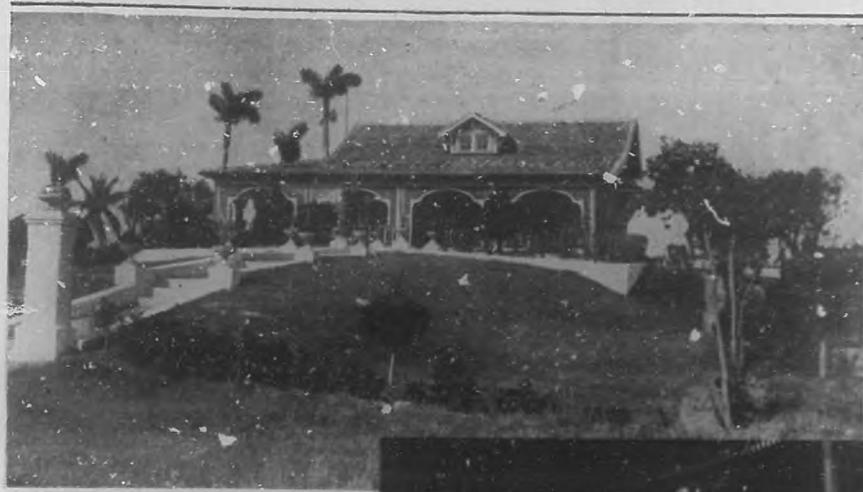
Un aspecto de la Casa que el Club de Cazadores del Cerro, posee en sus terrenos de "El Lucero".
